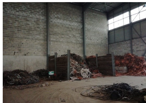
Bâtiment mixte – intérieur hangar métaux
