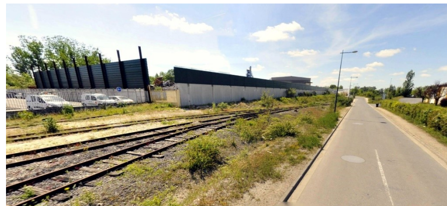
Vue sur la parcelle prévue pour le bâtiment « démantèlement »
