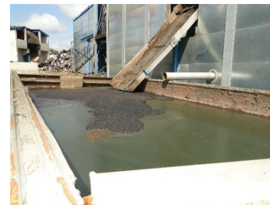
FIGURE 46 : BENNE DE COLLECTE DES BOUES ISSUES DU DEPOUSSIEREUR
