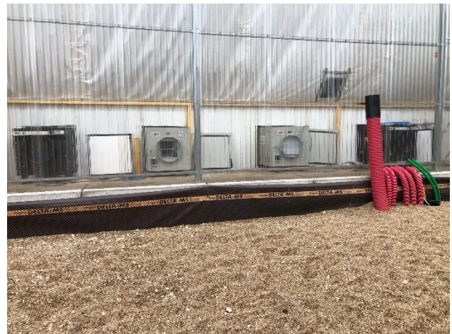
FIGURE 49 : BATIMENT DE DEMANTELEMENT - SYSTEME D'EXTRACTION D'AIR AVEC FILTRE TRES HAUTE PERFORMANCE
