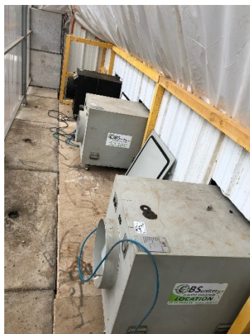
FIGURE 49 : BATIMENT DE DEMANTELEMENT - SYSTEME D'EXTRACTION D'AIR AVEC FILTRE TRES HAUTE PERFORMANCE
