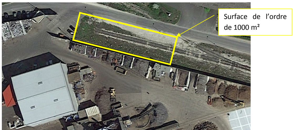
FIGURE 32 : ZONE VISEE PAR LES TRAVAUX POUR LA CONSTRUCTION DU BATIMENT « DEMANTELEMENT »
