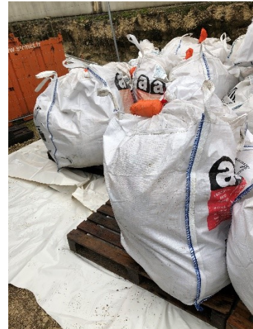
FIGURE 39 : CONDITIONNEMENT DES DECHETS AMIANTES
